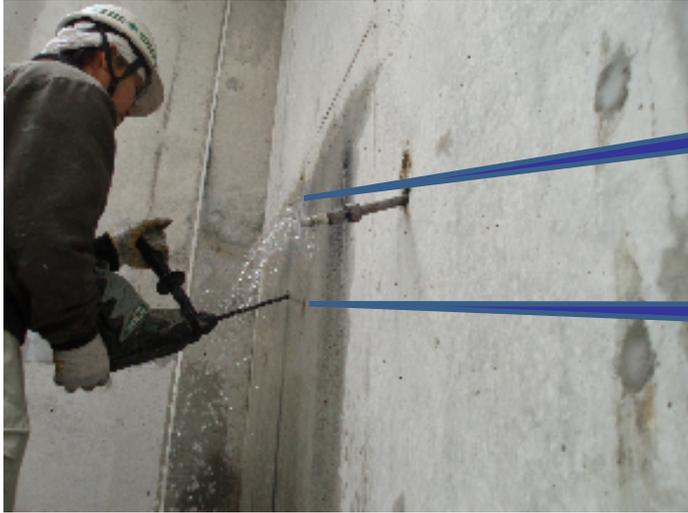
ピット壁面ジャンカーより漏水
